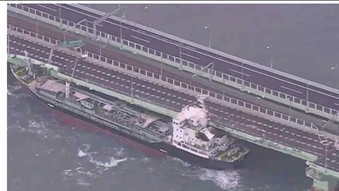
関西空港の連絡橋に衝突したタンカー （国土交通省近畿地方整備局HP）
