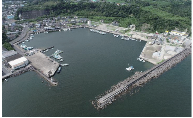
【写真-2 本港地区】 (小型船だまり)
