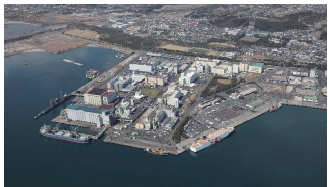
【写真-4 若浜地区】 (フェリーターミナル・配合飼料工場)
