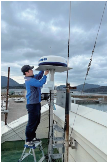
【レーダーアンテナ設置工事】
