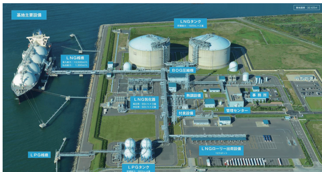
図 2 外観と各設備
