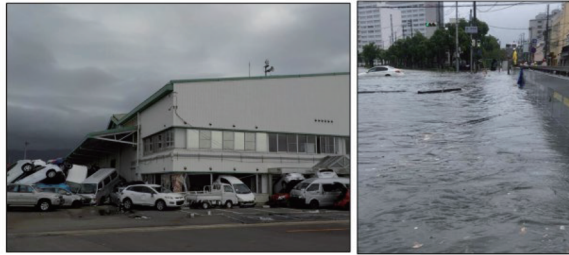
高潮被害（神戸市より提供） 左：車両流出 右：道路冠水
