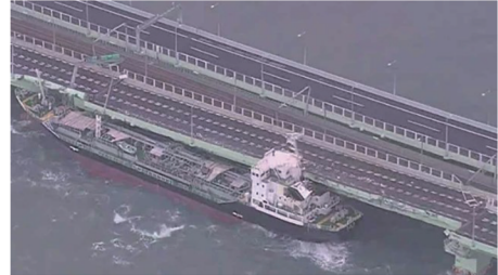
関西空港の連絡橋に衝突したタンカー （国土交通省近畿地方整備局HP）
