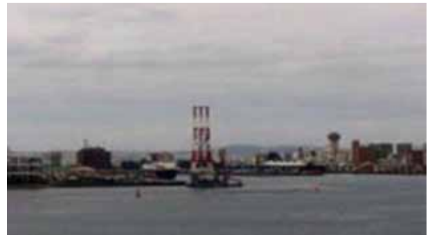
工事海域付近映像（監視カメラ B）
