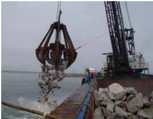
写真1 捨石（石材）投入状況
