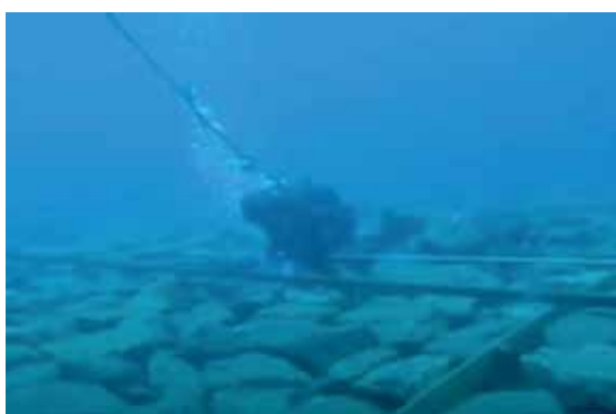
写真4 潜水士による均し作業
