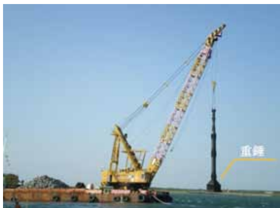
写真2 起重機船による重錘均し
