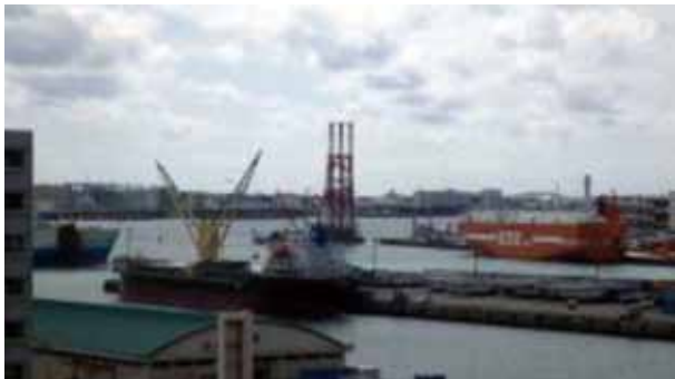
工事海域付近映像（監視カメラ A）
