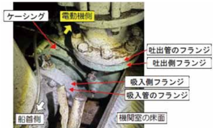
写真 2-15 冷却海水ポンプの取り付け状況
