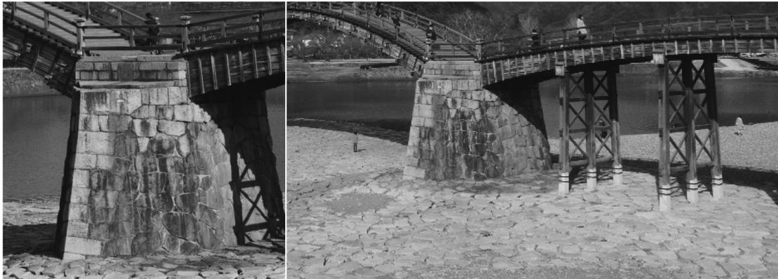
図5 現在の橋脚と護床工（上流約 20m、下流約 50m の範囲に敷石が施されている）
