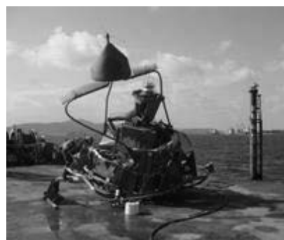
(2) 引揚げられた折損脱落部
