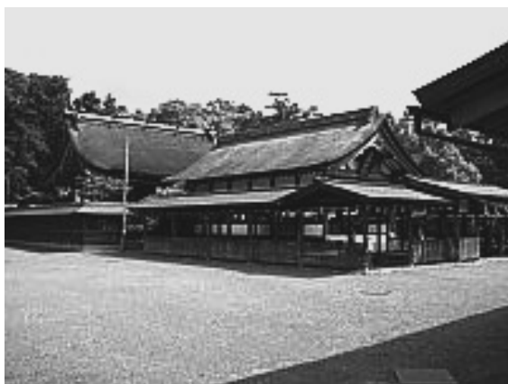
本殿・拝殿（現在改修工事中） （改修前 Town Munakata HPより）
