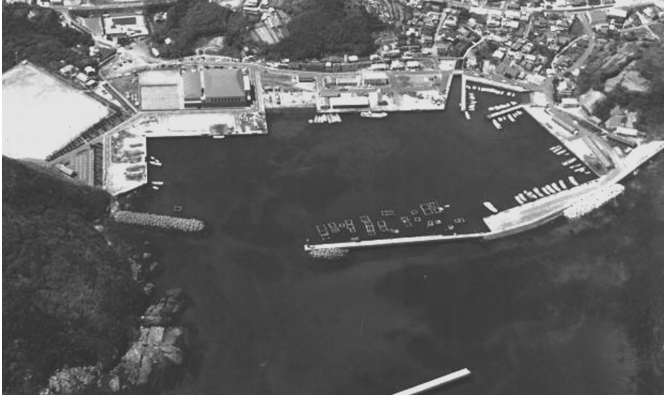
丸尾漁港（第一種漁港） （長崎県南松浦郡新上五島町）
