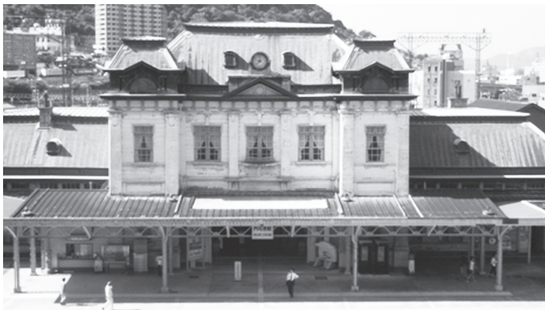
保存修理工事に入った門司港駅（東京丸の内駅舎より古い）
