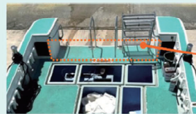
写真2 仕切り板の取り付け
